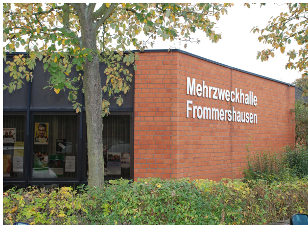
die Mehrzweckhalle Vellmar Frommershausen war Turnierort
